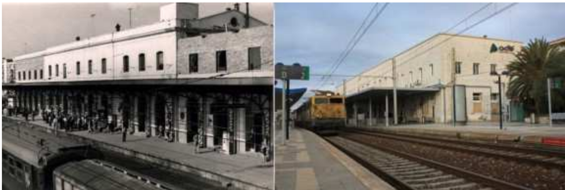
En la primera fotografia, imatge antiga de l'estació de Tarragona; en la segona, imatge actual de l'estació. Foto: MFCVG / JMM
